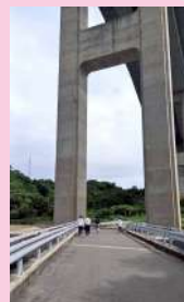
来島海峡大橋の橋下
