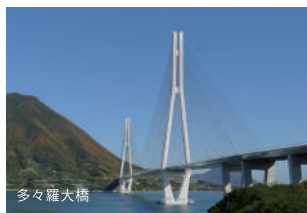
多々羅大橋
